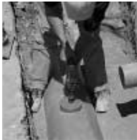
Do stěny očištěné trubky se pomocí vrtáku KGEAMV kolmo vyvrtá otvor o průměru 152 mm \pm 0,5 mm.
