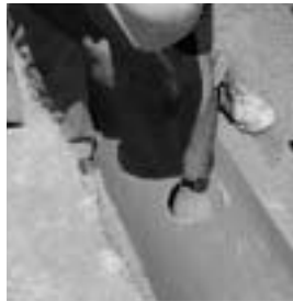
Z okrajů vrtu se odstraní otřepy pomocí nože nebo pilníku.
