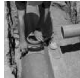
Zasune se odbočka a klíč KGEAMK se dotáhne její zajišťovací matice.
